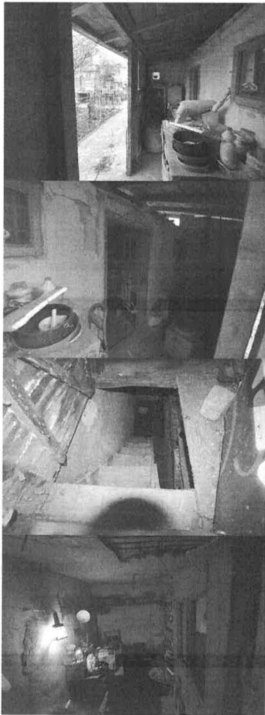
Vedere proprietate subiect – C3:
